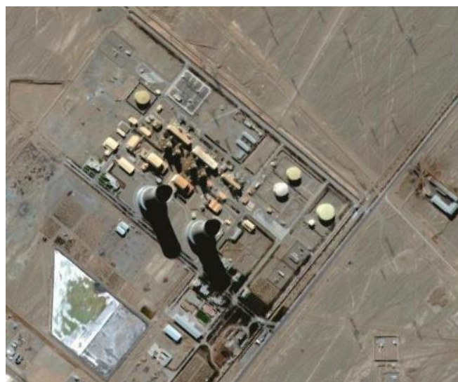
تصویر (۱): تصویر هوایی نیروگاه سیکل ترکیبی یزد
