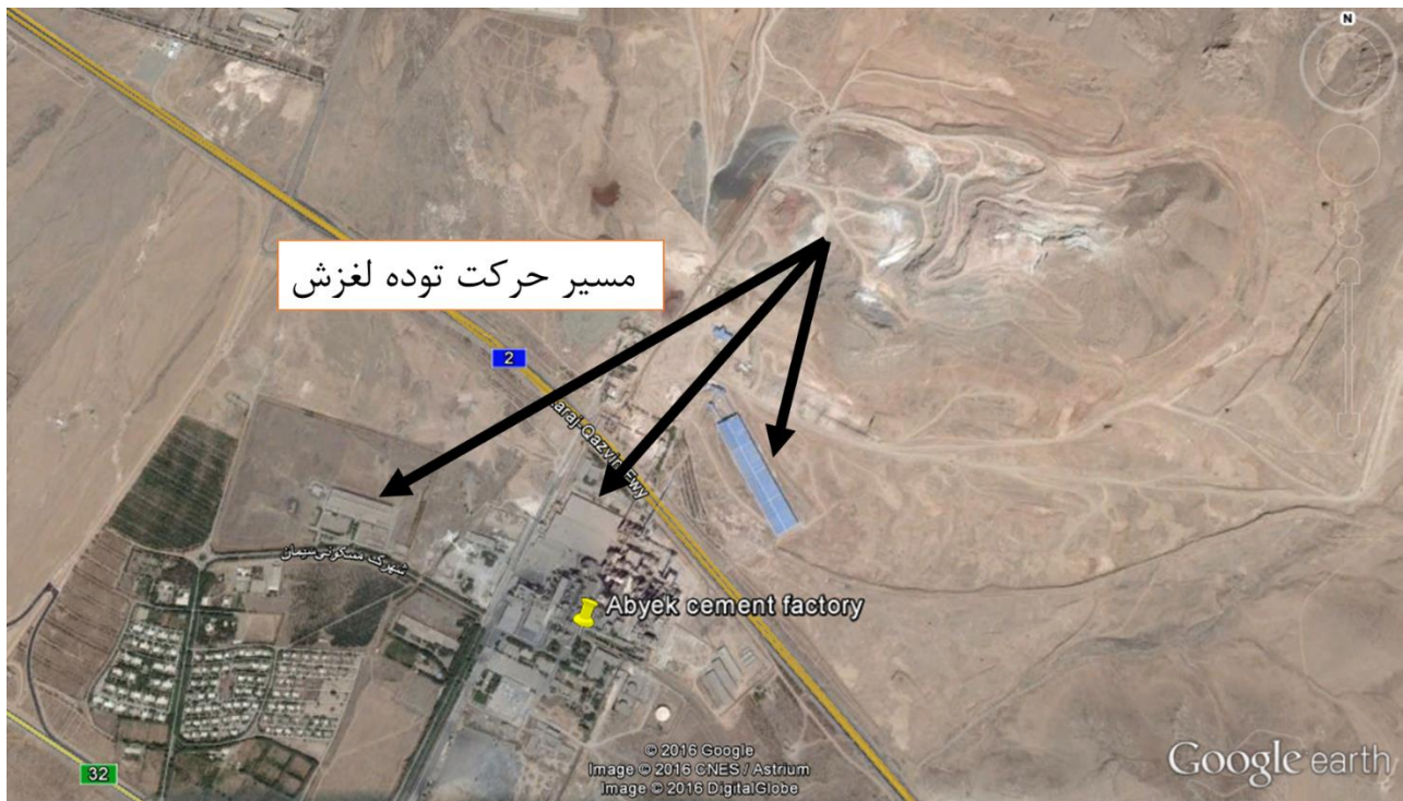
شکل (۶): مسیر حرکت توده لغزش در مجاورت مجموعه سیمان آبیگ
